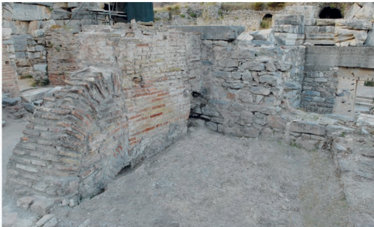
1 Nordöstliche Außenseite des Tempels mit später angesetzten Ziegelstrukturen
