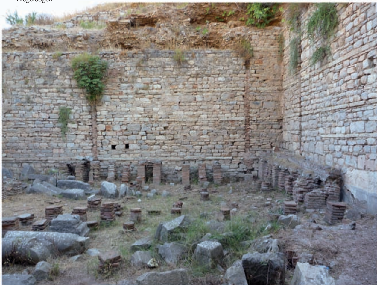
2 Raum 6 des Variusbades, Nord- und Ostwand
