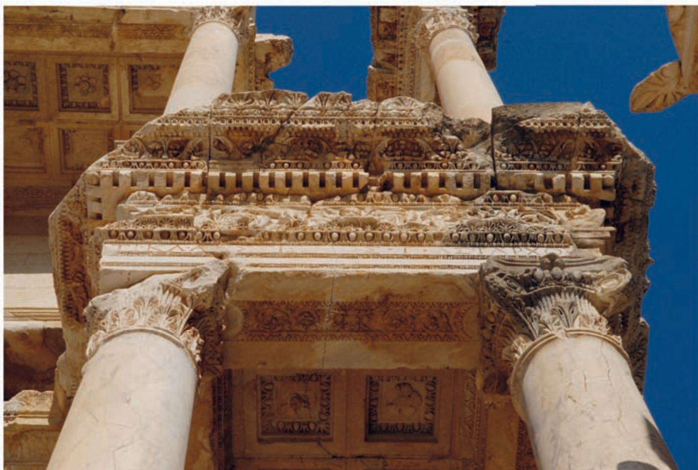
2 Nördlichstes Interkolumnium der Celsusbibliothek, Gebäk
