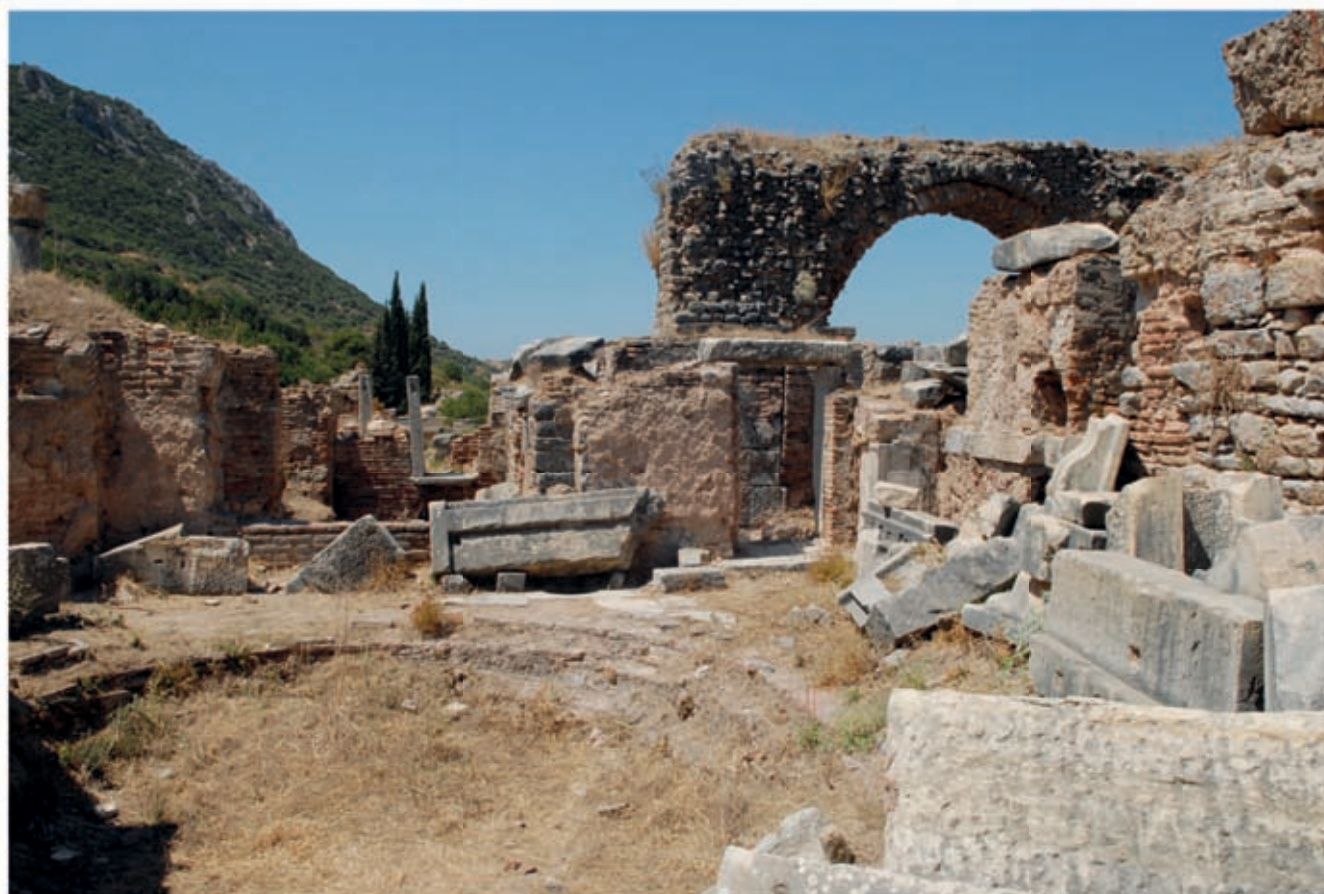
2 Raum 3, Blick nach Westen: originaler Baubestand des Variusbades durchsetzt mit Ziegelmauern und weiteren späten Einbauten; im Vordergrund ein Wasserbecken
