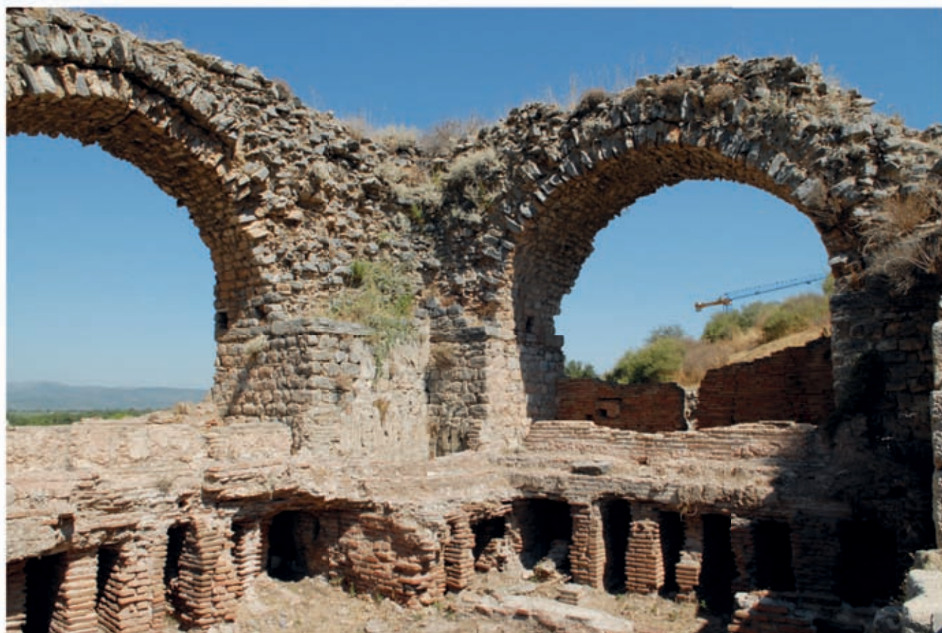
2 Variusbad, Raum 7. Blick nach Nordwesten
