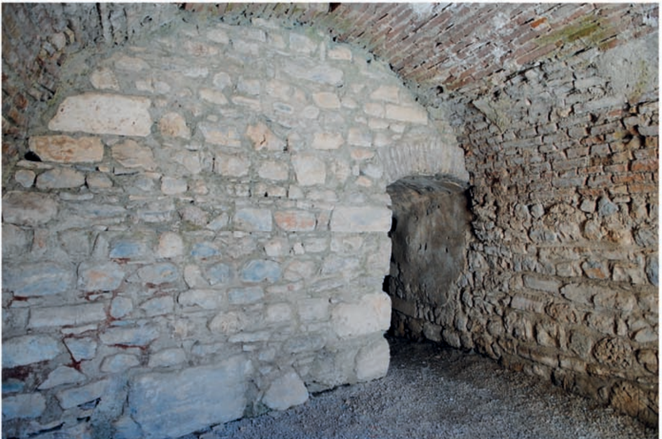
2 Substruktionen im südwestlichen Bereich des Variusbades mit originalem Baubestand aus Bruchsteinmauerwerk und später ausgeführten Reparaturen aus Ziegeln
